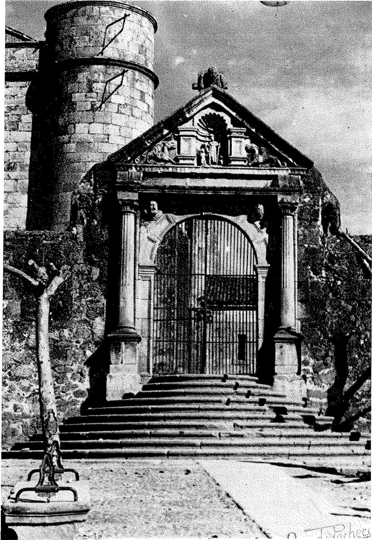
Fachada Hospital San Roque. Situación actual
